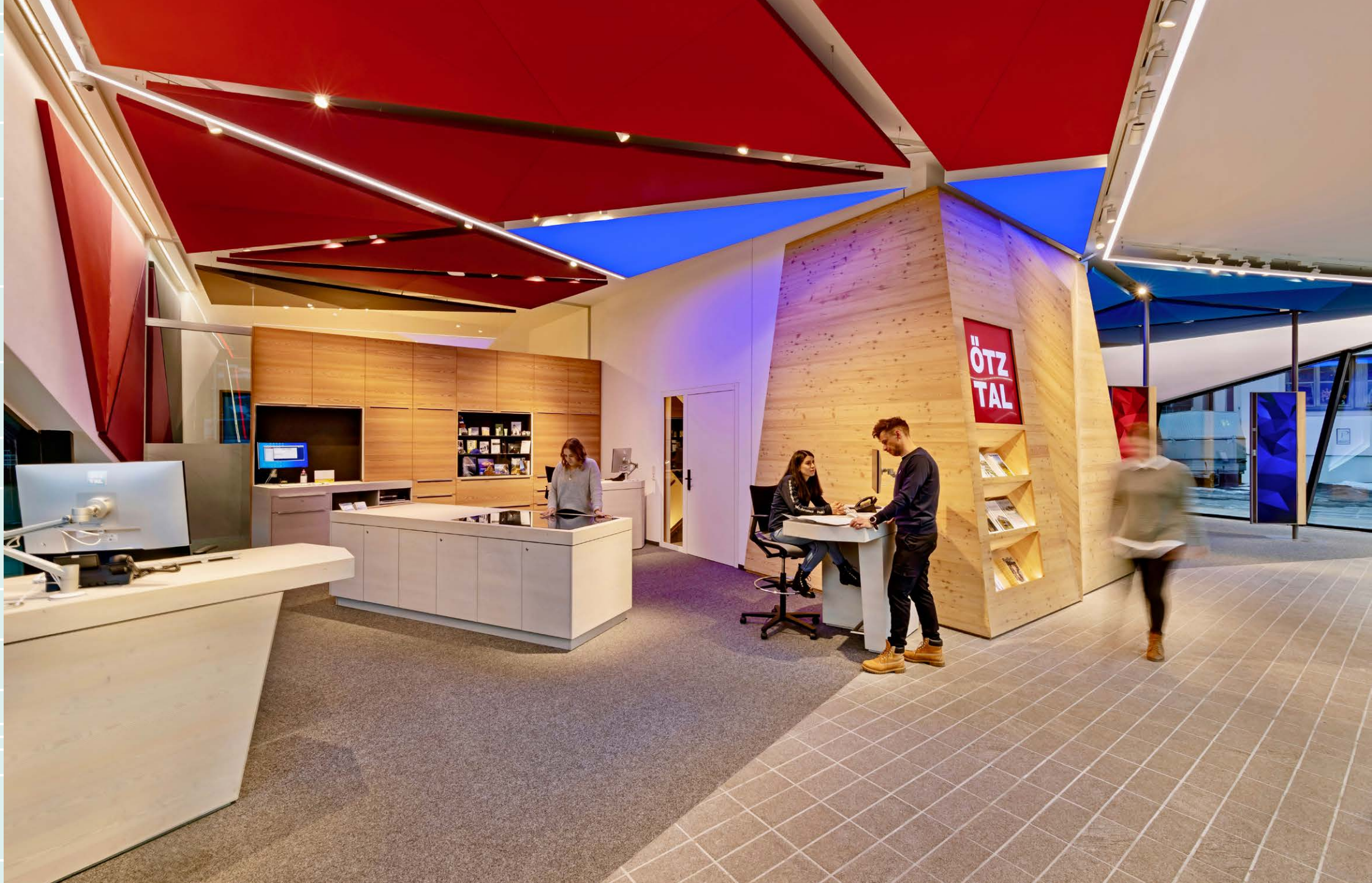
Akustikdecken, Lichtdecken integriert in das Raumdesign
